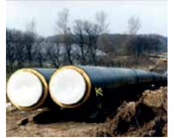
JEOTERMAL BORUNUN ARAZİYE DÖŞENMESİ
